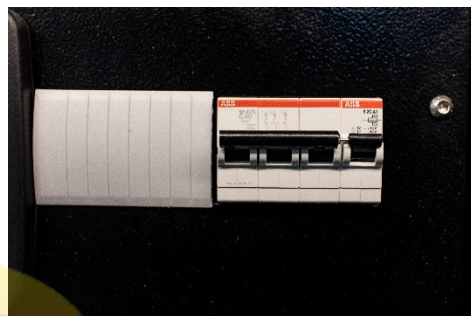
Электрическая часть ДГУ производства АВВ
