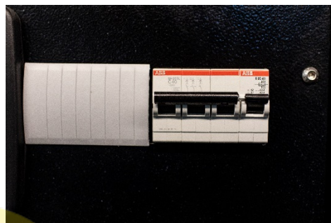
Электрическая часть ДГУ производства АВВ
