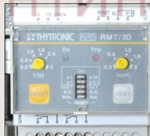
INTERRUTTORE DIFFERENZIALE EARTH FAULT BREAKER
